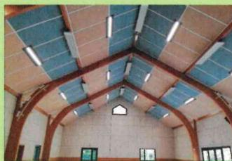
De nombreuses lampes ne fonctionnant plus, nous avons remplacé l'ensemble par des luminaires LED moins énergivores.
